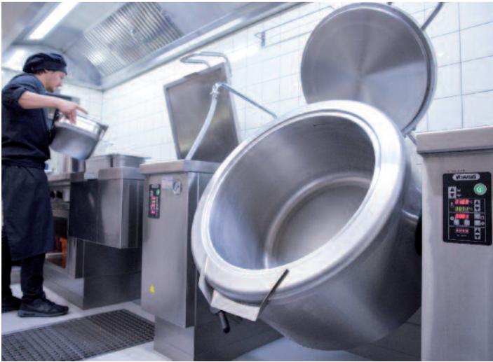
Herzstück der kompakten Bistro-Küche sind die Induktionsherdanlage sowie die Kipp-Gruppe mit Kippkochkessel und Kippbratpfanne des indonesischen Küchengeräte-Herstellers Nayati, welcher in der Schweiz durch die Generalimporteurin Gamatech AG vertreten ist.
