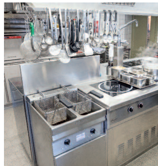
Im Mittelpunkt der von der Gamatech AG (Illnau) konzipierten und realisierten neuen Hecht-Küche steht eine beidseitig bedienbare multifunktionale B-G-H-Herdanlage mit sechs Induktionskochfeldern, Bain-Marie, Mixer-Halterung, Multifunktionskippratpfanne und Doppel-Standfritteuse.
